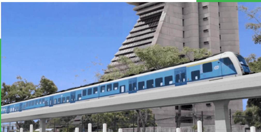
Fotografía de INCOFER.
