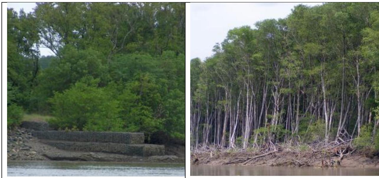
La construcción de estructuras como gaviones para estabilizar una sección del cauce puede ocasionar un cambio en la dirección de la corriente del río y erosionar otra sección del cauce como el presente ejemplo. Río Tempisque.
